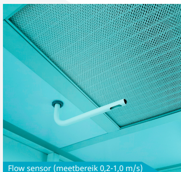
Flow sensor (meetbereik 0,2-1,0 m/s)
